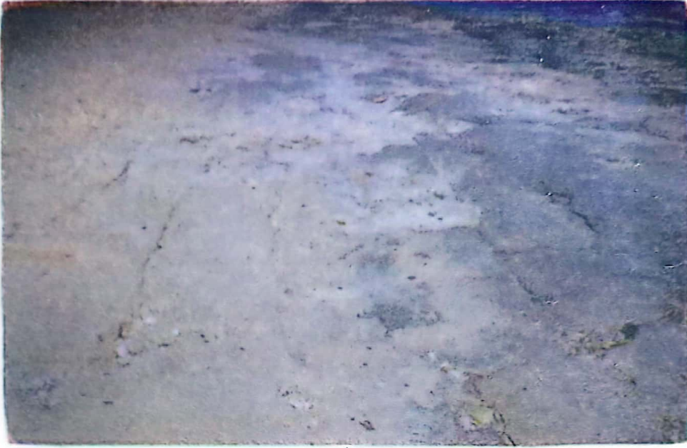
الشكل (43) : يوضح عملية قطع الحجارة من على شاطئ البحر مباشرة والتي استخدمت في تشييد فيلا شاطئ الحمام .
