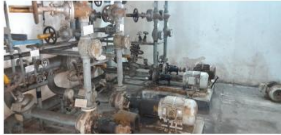
شكل رقم (2) مضخة مياه التغذية الاحتياطية
