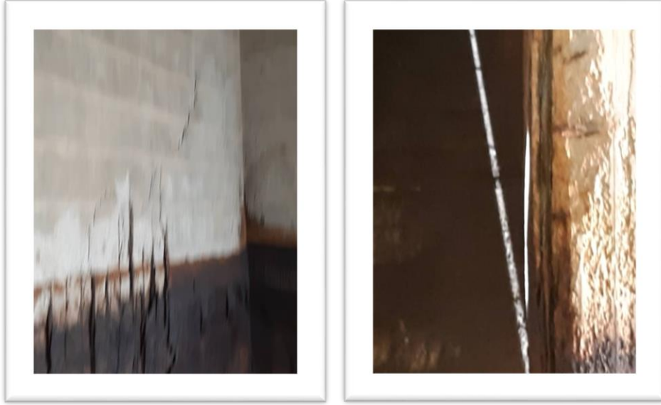
الشكل رقم(6) يبين الاضرار في قناة أسفل المضخات.
