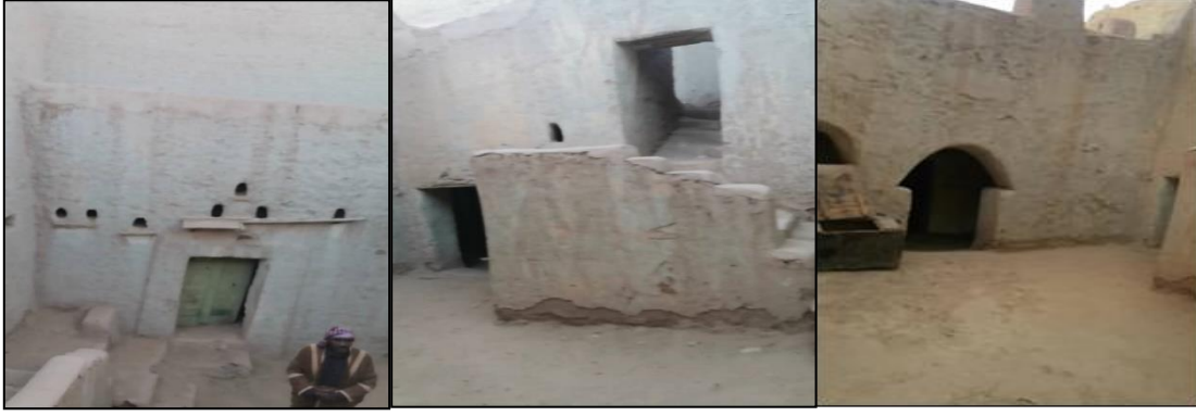
شكل (14) يبين أرضية الفناء والفتحات التي تستخدم للتهوية داخل الغرف بمسكن غات التقليدي [17]
