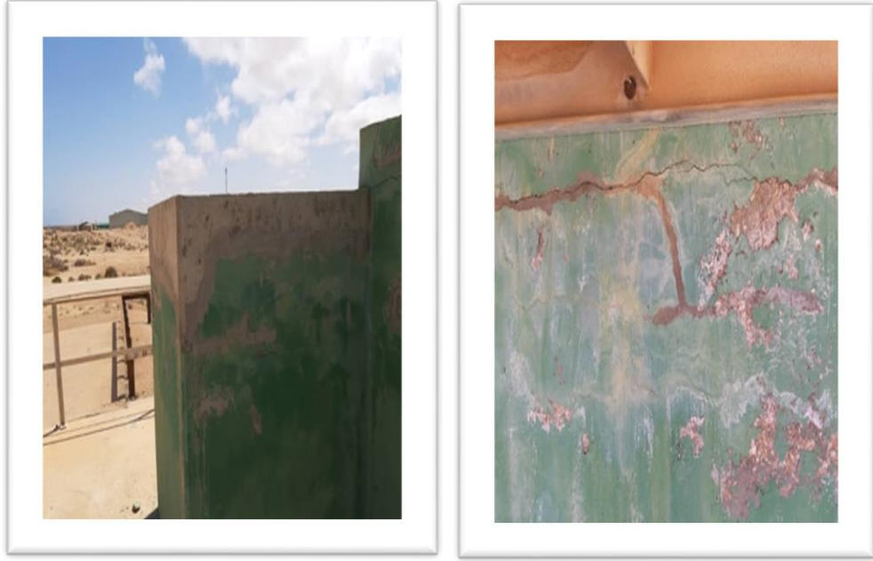
الشكل رقم(4) يبين الاضرار في قواعد المولد والمضخات.
