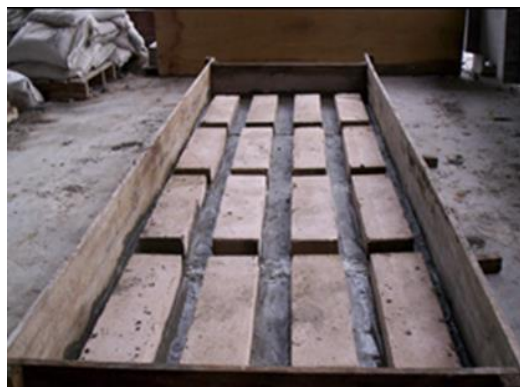
(d) AAC laid in position
