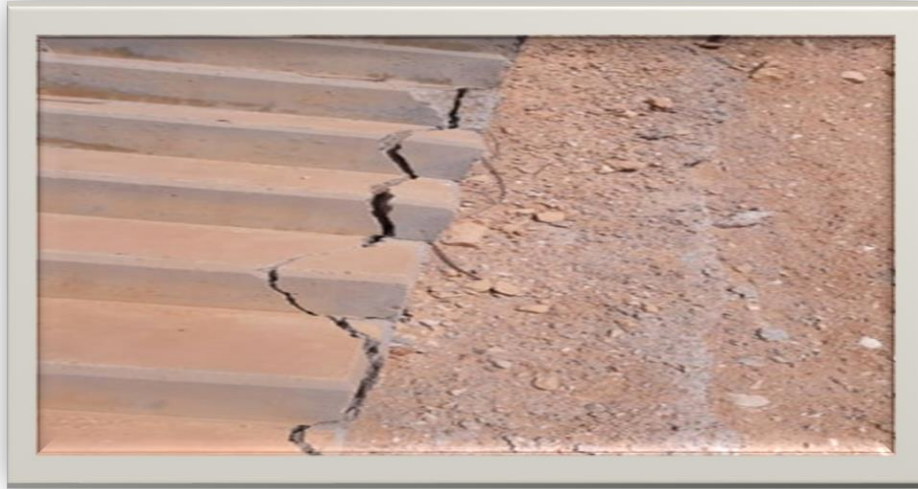
الشكل رقم(2) يبين الاضرار في الدرج.
