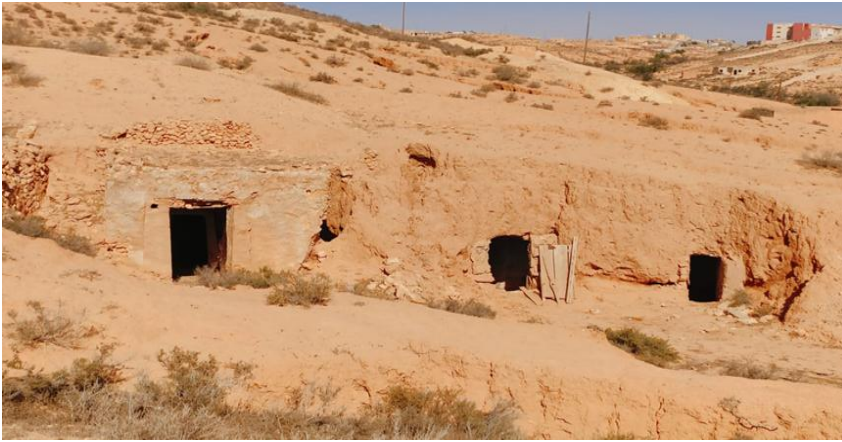
صورة (4) دواميس فردية مبطنة بالمونة غير الاسمنتية.
