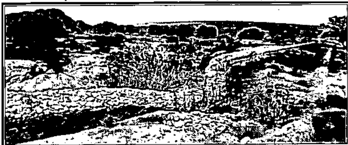
صورة رقم ( 6 ) سد تعويقي محطم بفعل السيول والفيضانات - وادي الحنيوة .
